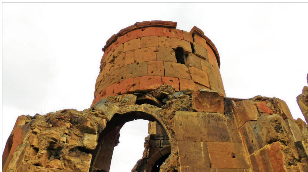
Նկար 47. Վեցխորան եկեղեցու վերակառուցված գմբեթի կլոր թմբուկը Фото 47. Реконструированный круглый барабан купола шестиапсидной церкви
