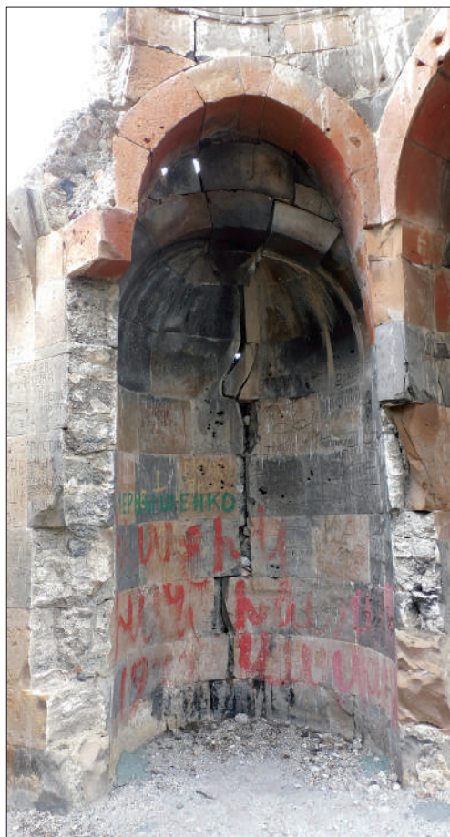
Նկար 58. Վեցխորան եկեղեցու հյուսիսարևելյան խորանի ճաքը
