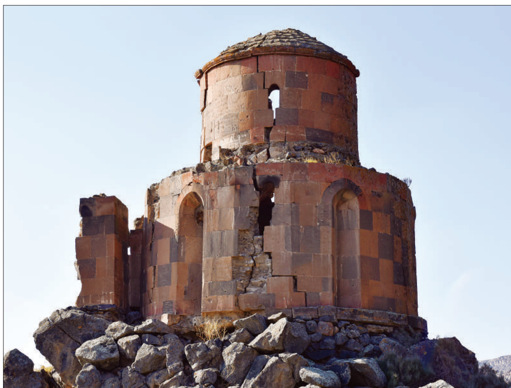
Նկար 56. Վեցխորան եկեղեցու պատի և գմբեթի արևելյան ճաքը
