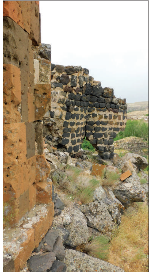
Նկար 54. Քառախորան եկեղեցու՝ սողանքի հետևանքով թեքված պատերը
