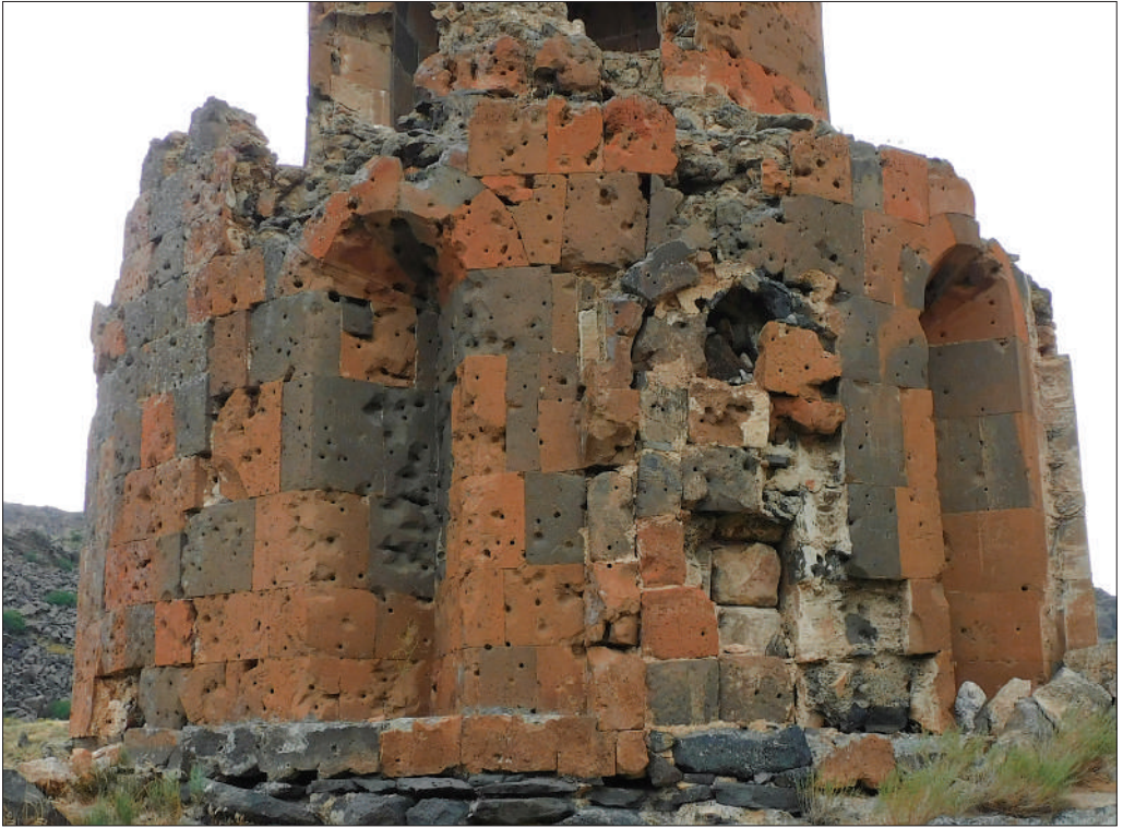
Նկար 60. Վեցխորան եկեղեցու հյուսիսարևմտյան գնդակոծված պատը Фото 60. Поврежденная в результате обстрелов северо-западная стена шестиапсидной церкви
