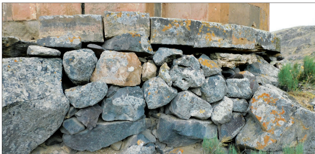
Նկար 55. Վեցխորան եկեղեցու գետնախարսխի տակ հարթեցնող շերտը
