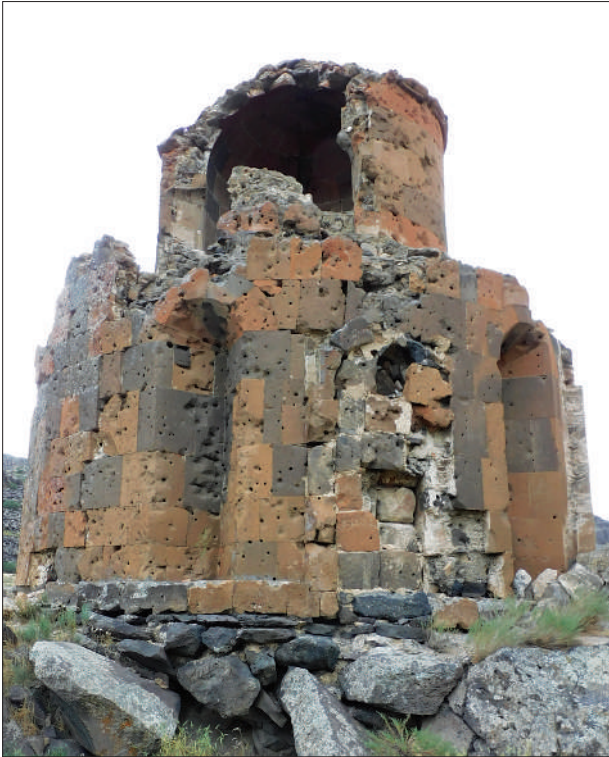
Նկար 49. Վեցխորանի գմբեթի հյուսիսարևմտյան փլված հատվածը
