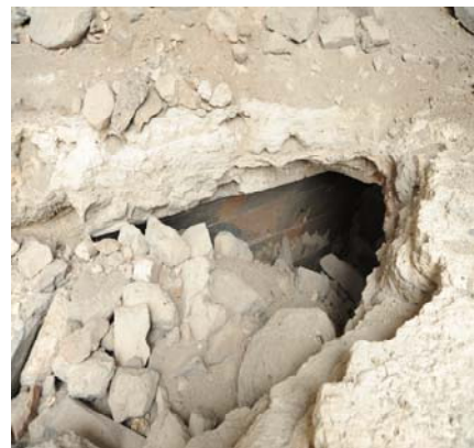
Նկ. 4. Խորանի տակի թաղակապ սենյակը և կրաբետոնե պլատֆորմը
