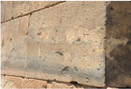
Նկ. 7. Շարվածքի հատված. երևում է անկյունային փորվածքով քար և վարպետի նշարագիր
