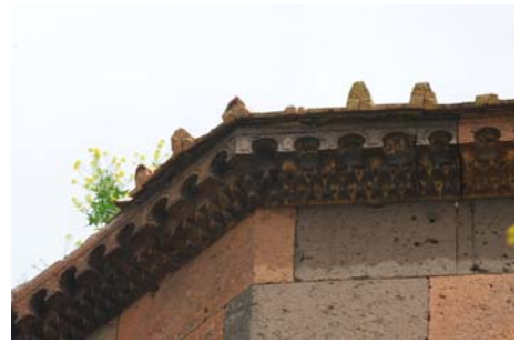
Նկ. 8. Թմբուկի քիվը և գմբեթի վեղարի ստորին շարքի կղմինդրները
